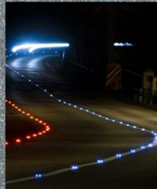
Las violetas se utilizan para delimitar carriles y brindar mayor seguridad al tráfico vehicular nocturno. Su fijación es con tornillo y taquete expansivo para concreto o asfalto.
