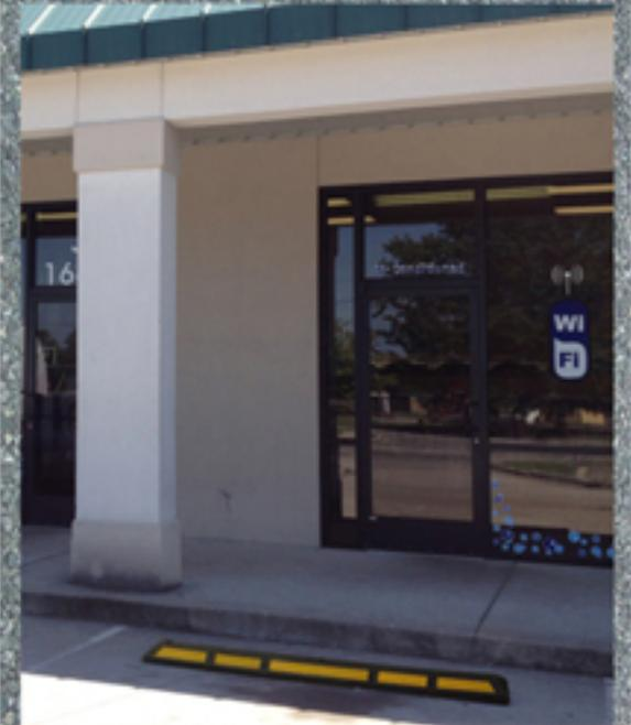
El tope está diseñado para usarse en cajones de estacionamiento y poder delimitar el avance del automóvil. Su instalación se realiza mediante la inserción de tornillo y taquete.
