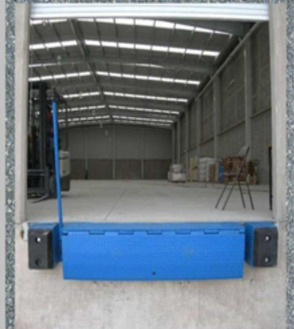
Estos topes se utilizan para proteger el andén de impactos causados por los vehículos de carga y descarga. Su instalación es sencilla ya que se realiza a base de tornillo y taquete.
