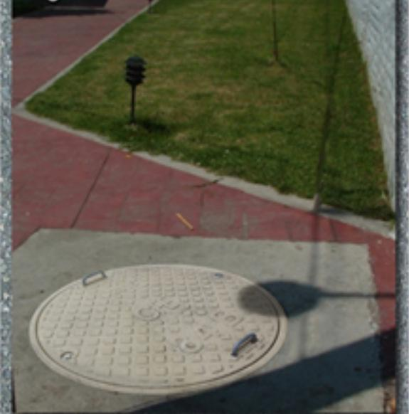
Esta pieza está diseñada bajo las especificaciones de CFE para poder soportar grandes cargas puntuales, lo que la hace factible y resistente para ser instalada en banquetas. No es recomendable su instalación en vialidades vehiculares.
