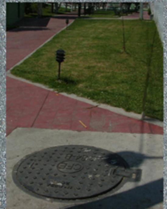
Esta pieza se diseña bajo las especificaciones de CFE para poder soportar grandes cargas puntuales, lo que la hace factible y resistente para ser instalada en banquetas. No se recomienda su instalación en vialidades.
