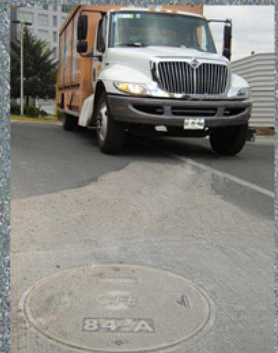
Esta pieza está diseñada bajo las especificaciones de CFE para poder soportar cargas vehiculares, pudiendo ser instalada en vialidades.
