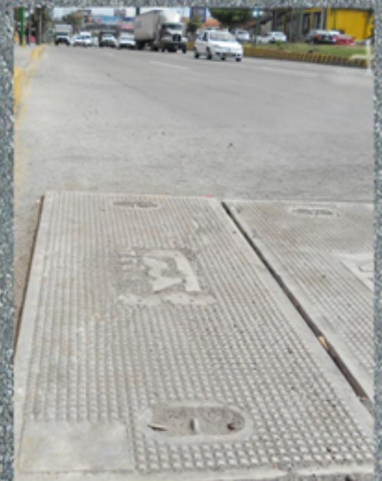
Esta pieza se utiliza para cubrir o tapar los registros de cableado telefónico y soporta grandes cargas, por lo cual su instalación puede ser en banquetas o vialidades sin gran carga vehicular.
