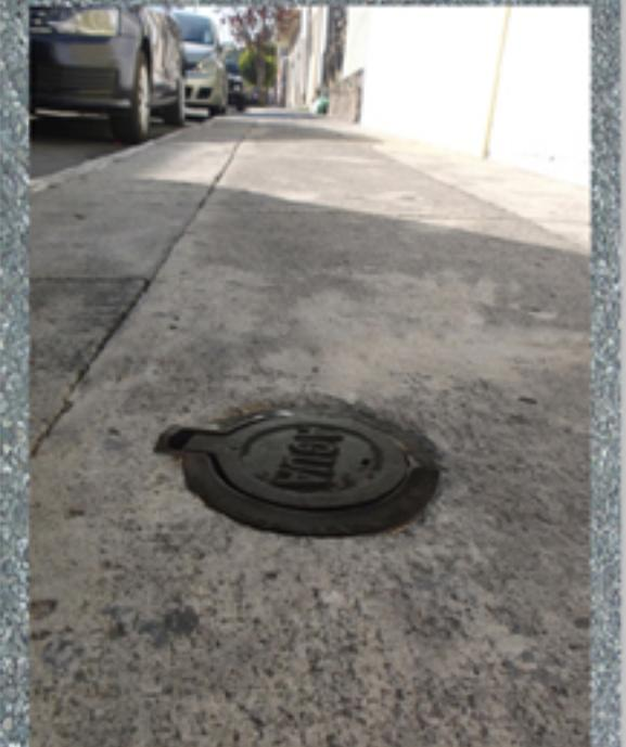
Esta pieza es utilizada como registro para las válvulas de control de flujo. Por el reducido tamaño de la tapa, esta puede resistir cargas de tráfico.
