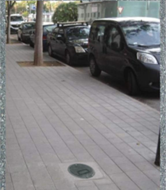
La pieza está diseñada para usarse en instalaciones eléctricas y telefónicas. Soporta grandes cargas sobre la tapa y se recomienda su instalación en aceras o jardines.
