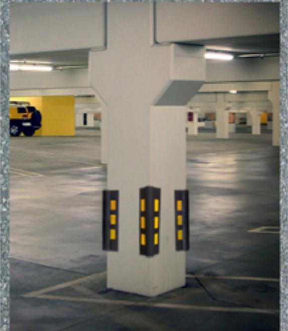
Diseñado para proteger las columnas de impactos producidos por vehículos. La pieza se fija a la columna con pegamento epóxico para evitar daños en el elemento estructural.
