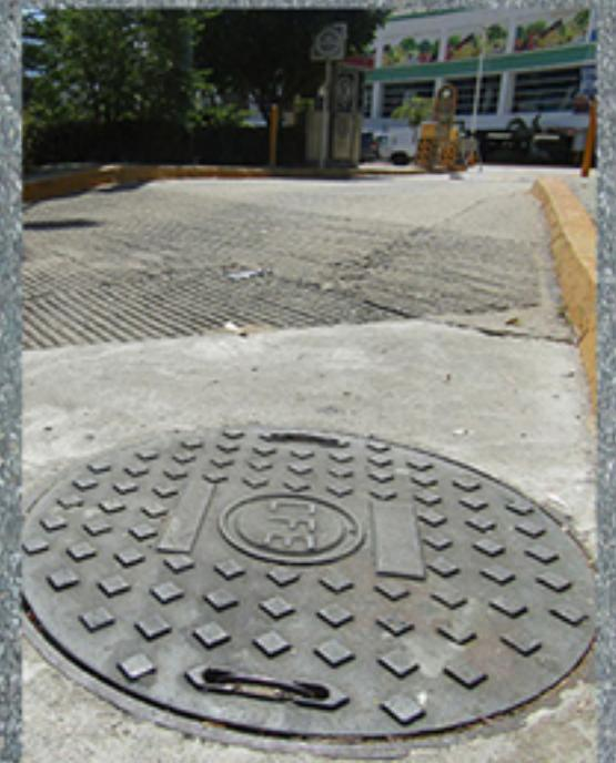
Esta pieza está diseñada bajo las especificaciones de CFE para poder soportar cargas vehiculares, pudiendo ser instalada en vialidades.
