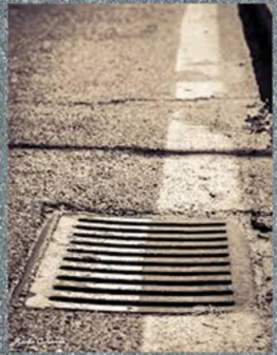
Esta pieza está diseñada para poder soportar las cargas de tráfico vehicular, lo que la hace factible para ser instalada en vialidades.
