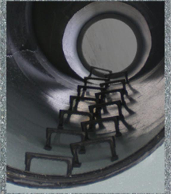
Estos escalones se anclan en el pozo de visita y se instalan a modo de zig-zag uno tras otro para un mejor desplazamiento.
