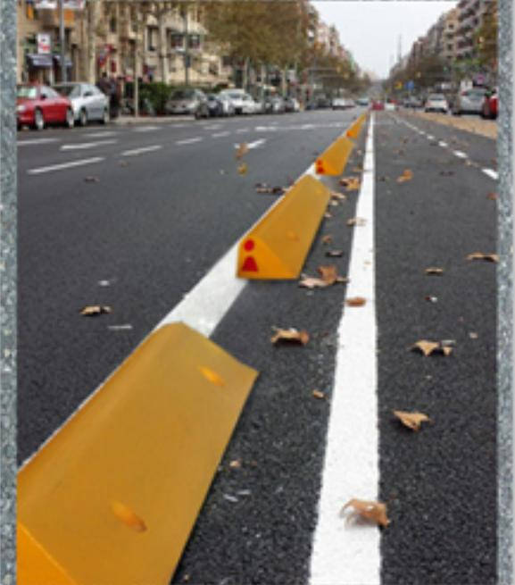
Esta pieza es utilizada para delimitar carriles especiales de circulación vehicular y brindar mayor seguridad. Su instalación se realiza mediante la inserción de tornillos y taquetes.
