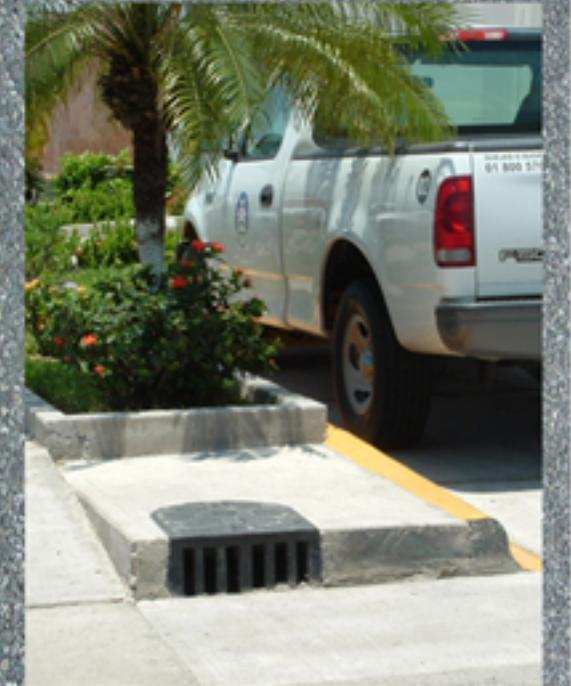
Esta pieza está diseñada para poder soportar cargas de hasta 6 toneladas, haciéndola factible para ser instalada en banquetas sin riesgo de fractura.
