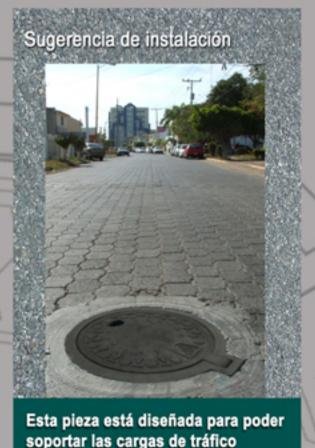
Esta pieza está diseñada para poder soportar las cargas de tráfico vehicular, lo que la hace factible para ser instalada en vialidades.
