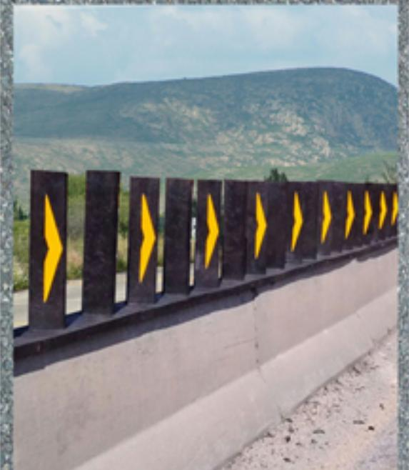
Diseñado para proteger a conductores de las luces o reflejos producidos por vehículos en el carril adjunto. La pieza se fija a la barrera por medio de tornillos y taquetes.
